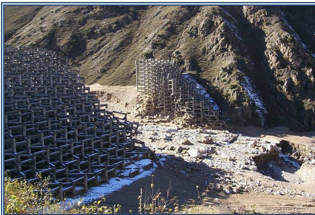
Рис. 9. Разрушенная селем 1999 г. плотина на р. Герхожан-Су
